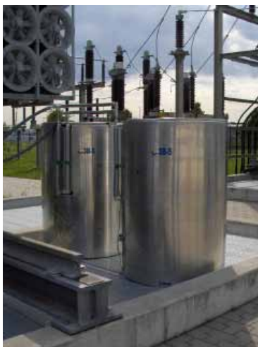
G3B型呼吸缓冲罐 用以延长变压器寿命
