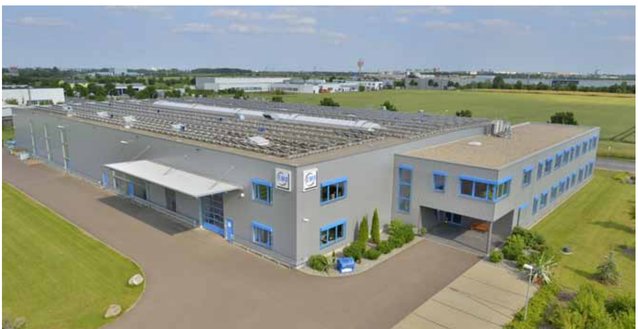
Edificio de la empresa EMB
